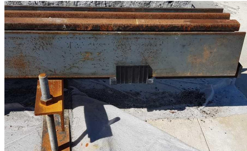
Pose ancrée sur résine
