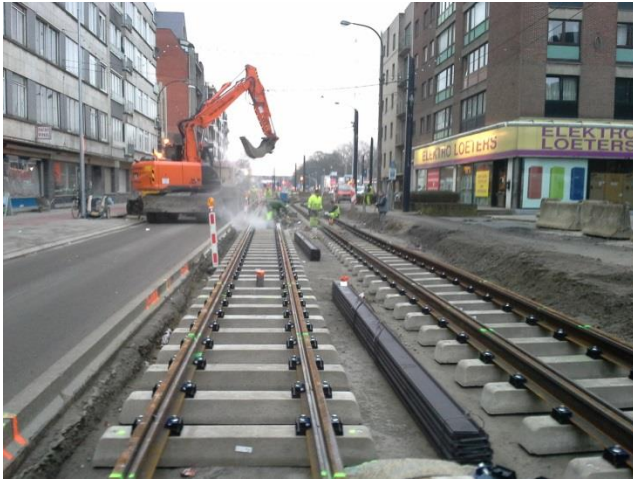
Pose sur traverse
