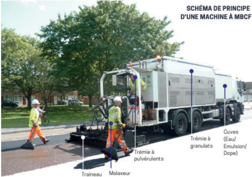
Figure n°2 : Synoptique d'une machine MBCF et vue du traineau d'apporteur
