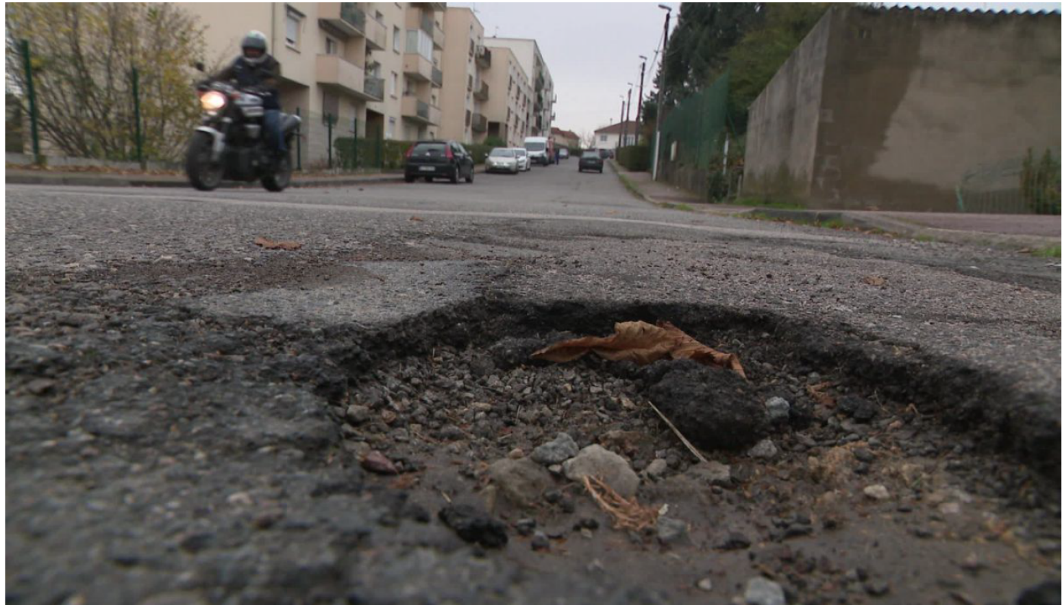
Les fortes pluies après un été très sec créent des infiltrations d'eau dans les chaussées. / © France 3 Limousin
