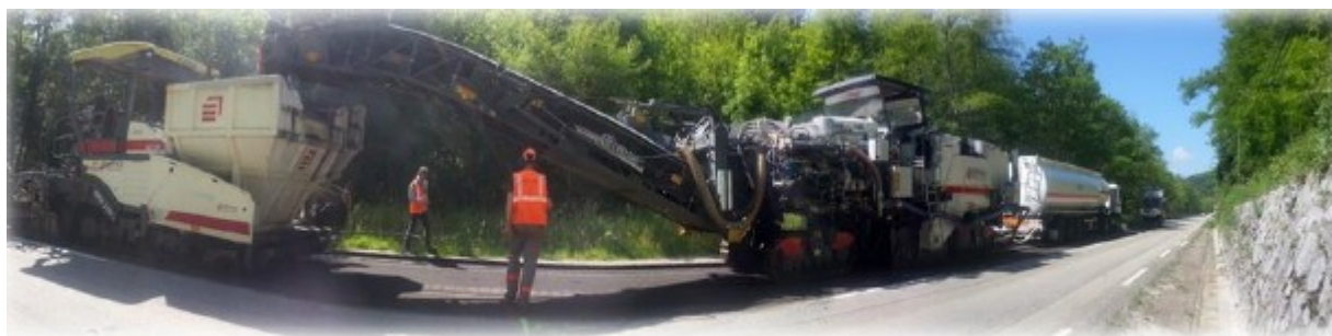
Atelier de retraitement en place ARM 2500 (Source Eiffage Infrastructures) lors d'un chantier sur une route départementale française.
